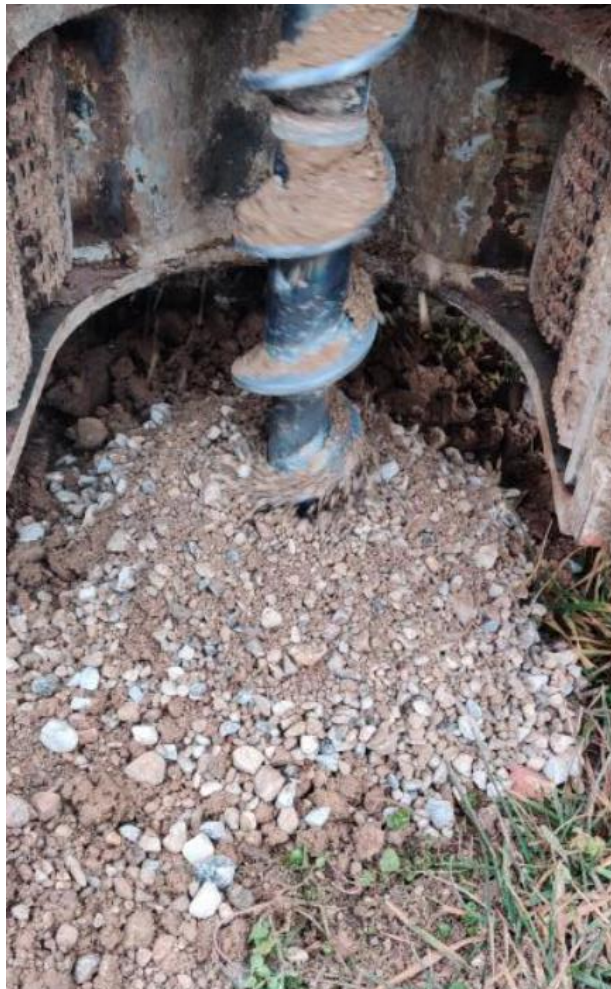
Vues du sol en place
